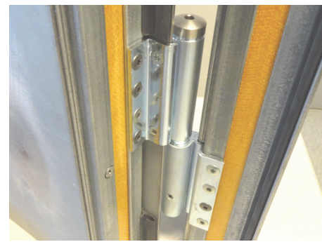
8) Cerniera su profilo ignifugo
