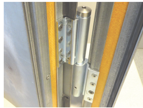
8) Cerniera su profilo ignifugo
